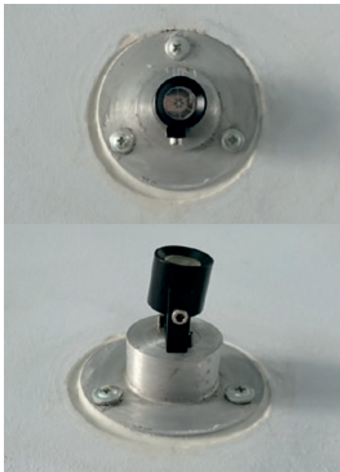
Пример расположения минипризмы на стене
