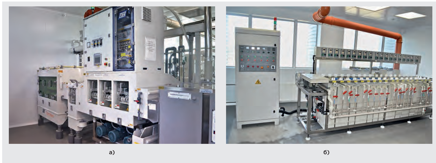
6 Участок «мокрых» процессов: а – конвейерная установка струйного проявления защитной паяльной маски. Шкаф управления, как обычно у Universal, смонтирован «вторым этажом»; б – линия иммерсионного золочения. Можно видеть индивидуальные пульта для каждой из ванн линии
