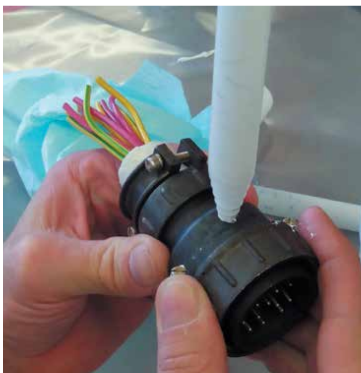
6 Заливка разъема серии ШР Виксинтом У-1-18 из Dorag Metamix
