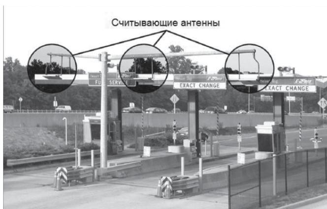
Рис. 9 Контрольно-считывающие стойки для грузовых автомобилей, расположенные в пункте таможенного контроля. Источник: Guidelines for Securing Radio Frequency Identification (RFID) Systems. Recommendations of the National Institute of Standards and Technology
