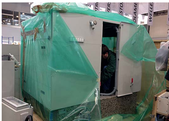
Монтаж одношпиндельного станка Posalux
