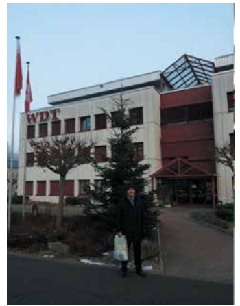
Здание головного офиса и завода компании WDT
