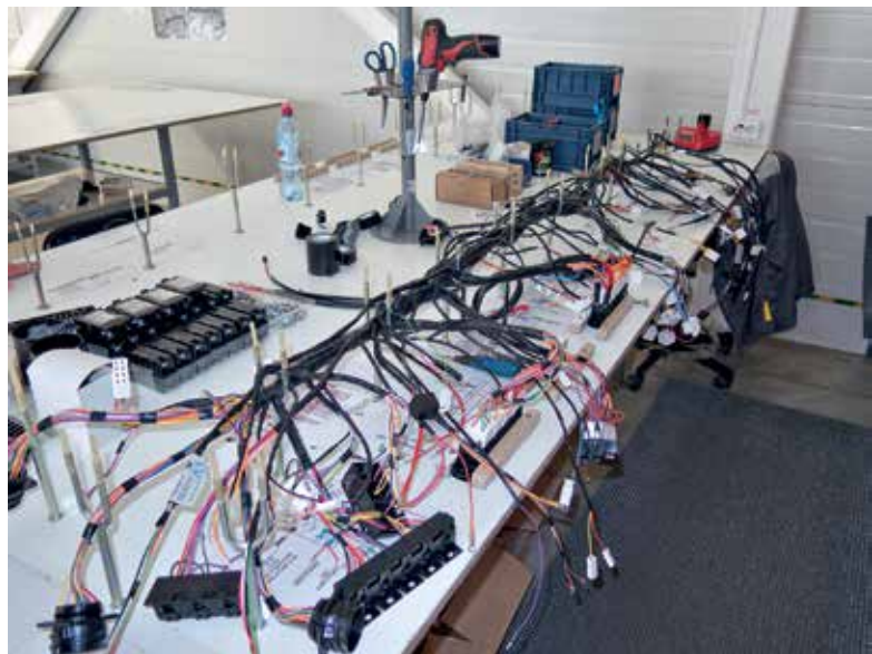
Финальный жгут, подготовленный для подключения к панели
