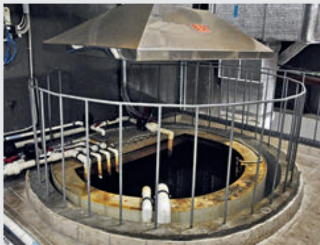
Основные агрегаты первой ступени очистки стоков: слева – генератор ферроферригидрозоля; справа – один из двух реакторов очистки
